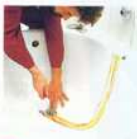
2 Entfernen von Ab- und Überlaufsieb an der alten Wanne.
