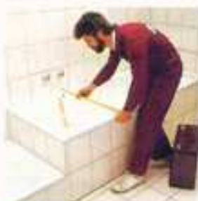
1 Maßnahmen für den präzisen Zuschnitt der neuen Wanne.
