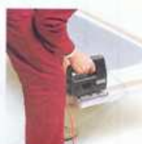
4 Zuschneiden der wandliegenden Seiten (außerhalb der Wohnung).
