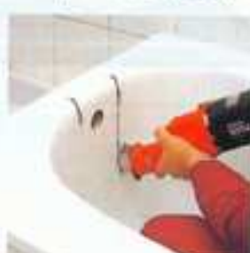
8 Aufschneiden der alten Wanne im Bereich von Ab- und Überlauf.
