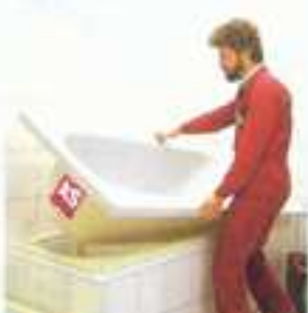
11 Anschließend wird die neue Wanne eingesetzt.
