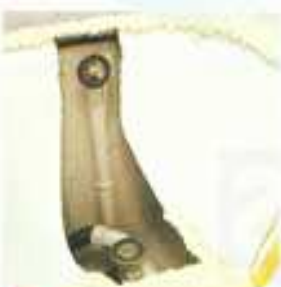
10 Verlegen der neuen Ab- und Überlaufgarnitur; Auftragen von PU-Schaum.
