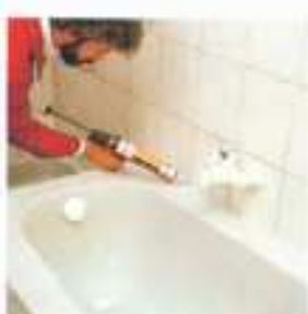
12 Montieren der Armaturen und ringsum Verfugen mit dauerelastischem Silikon.
