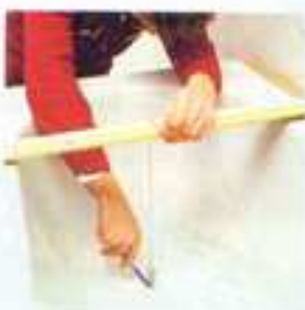
6 Maßübertragung für Ab- und Überlaufbohrung auf die neue Wanne.
