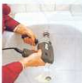
7 Bohren von Ab- und Überlauf und anschließendes Herausnehmen der neuen Wanne.
